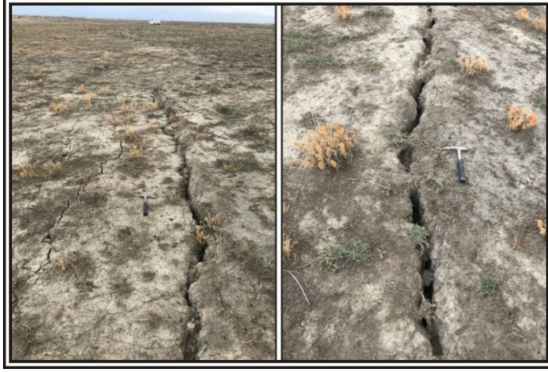
Şekil 4. Tuzlukçu bölgesinin batısında gözlenen K70°D doğrultulu asismik yüzey deformasyonları
